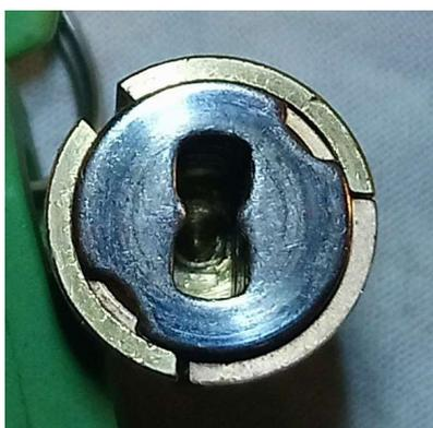
**Fig. 9. Disque anti-perçage, non cranté, peut être sûr n'importe quelle position (cadenas Anchor Las)**
